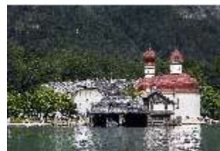
SBarth.I, Kapelle mit Anlegestelle, DI014781, BSV-
